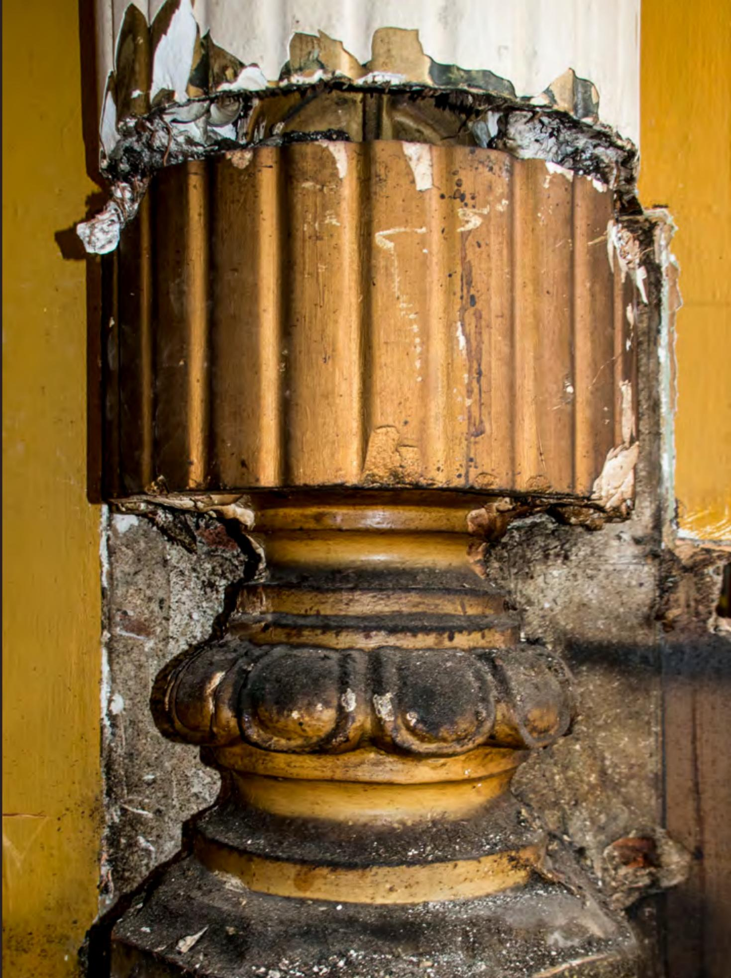
El desmontaje del mobiliario permitió volver a ver la base de los pilares de fundición fabricados por Laviada y Cía. en 1898, ocultos desde la reforma de 1931. Así mismo quedó a la vista el acabado dorado original de las columnas Art Decó.
