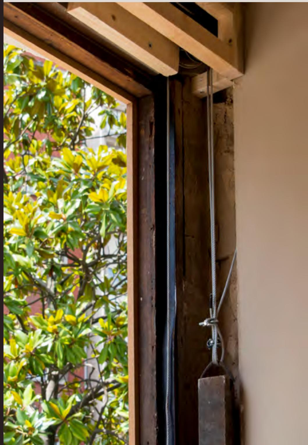
Tras ella se procedió a la recolocación del pavimento original, que se conservaba en buen estado —casi una tercera parte del total—, y a una minuciosa rehabilitación de la estructura de los ventanales, que incluyó la restauración del sistema original de apertura y cierre mediante poleas y contrapesos.
